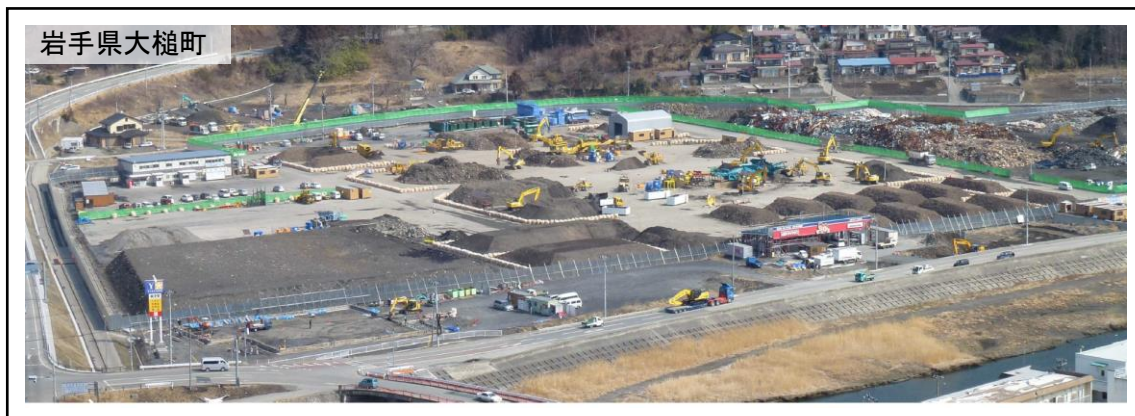
図 2-6-(10)-3 二次仮置場の例
