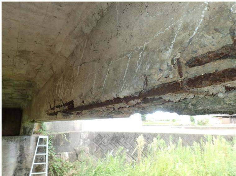
図 4-3 コンクリート橋の損傷状況
