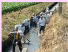
水路の泥上げ
