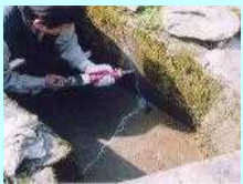
水路のひび割れ補修
