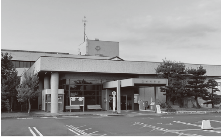
▲築40年経過した庁舎
