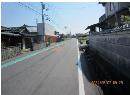
5.小学校南西道路
