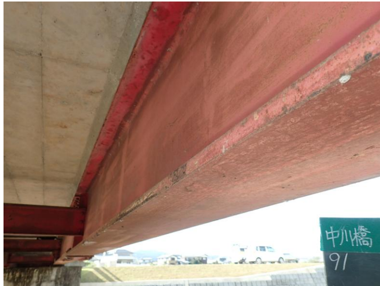
図 4-2 鋼橋の損傷状況
