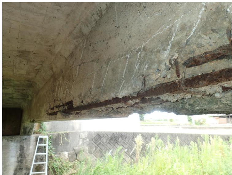
図 4-3 コンクリート橋の損傷状況
