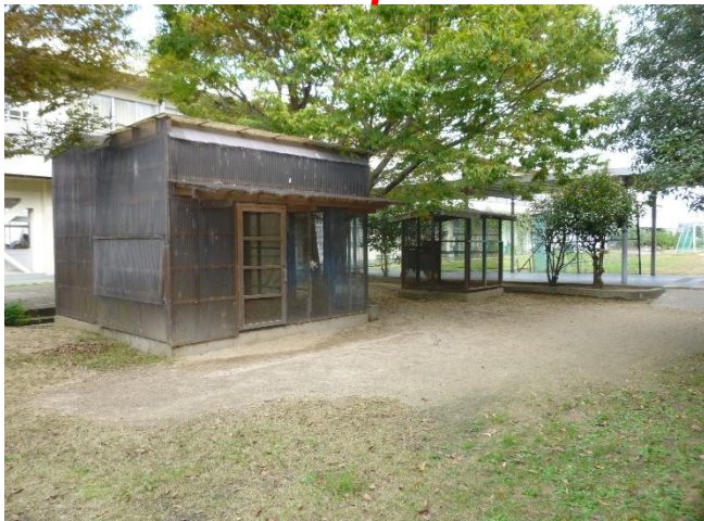
・ペットスペースとなるうさぎ小屋
