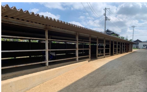
敷地北側 駐輪場
