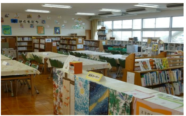
② 図書室：本棚が多数あり、固定されていないため転倒の恐れあり。使用前に状況を確認する必要がある。
