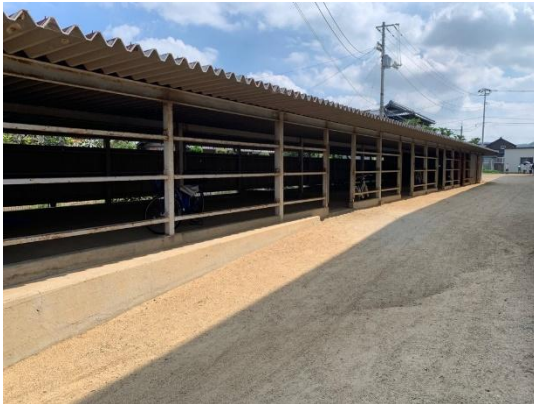
・ペットスペースとなる駐輪場
