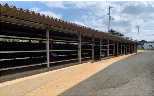
敷地北側 駐輪場
