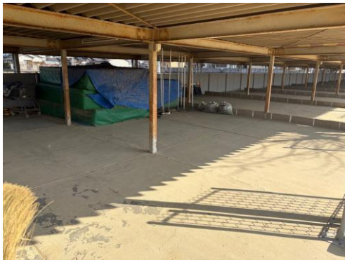
・ペットスペースとなる駐輪場
