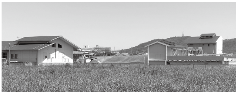
▲三木浄化センター
