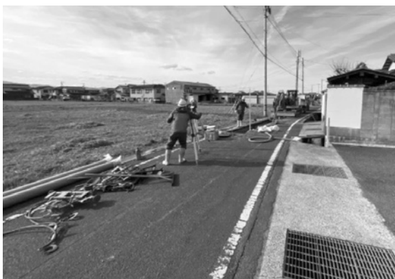
▲下水道工事の様子
