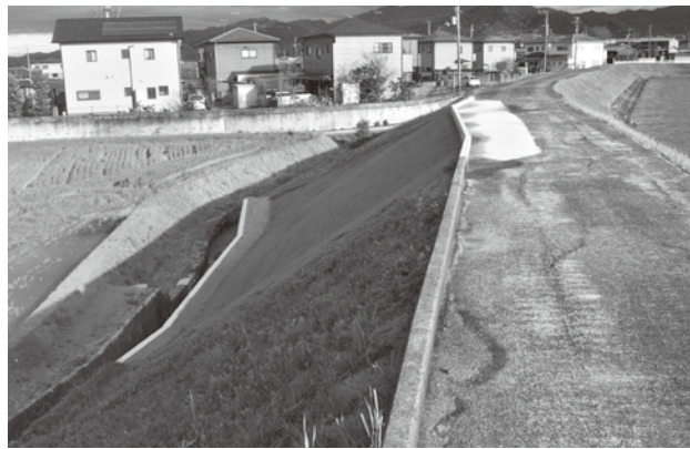
▲田中地区「大箕池」堤体改修工事
